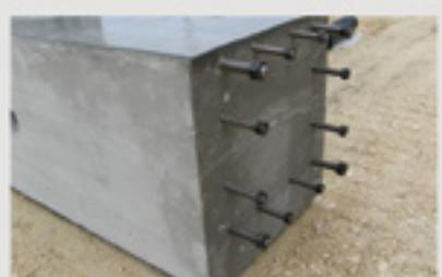
Montaža stubova na gradilištu vrši se na unapred nivelišane matice i podloške koje su navrnute na sidrene vijke. Stub se spušta na sidrene vijke, proverava se vertikalnost u dva ortogonalna pravca, postavljaju se gornje podloške i maticе. Maticе se pritežu običnim vilastim ili moment ključem. Pritezanje se može izvršiti i udaranjem čekićem na vilasti ključ i dovodi se do "snug-tight" pritegnutosti. Nakon toga stub se može otkačiti sa dizalice kojom je izvršena montaža.
