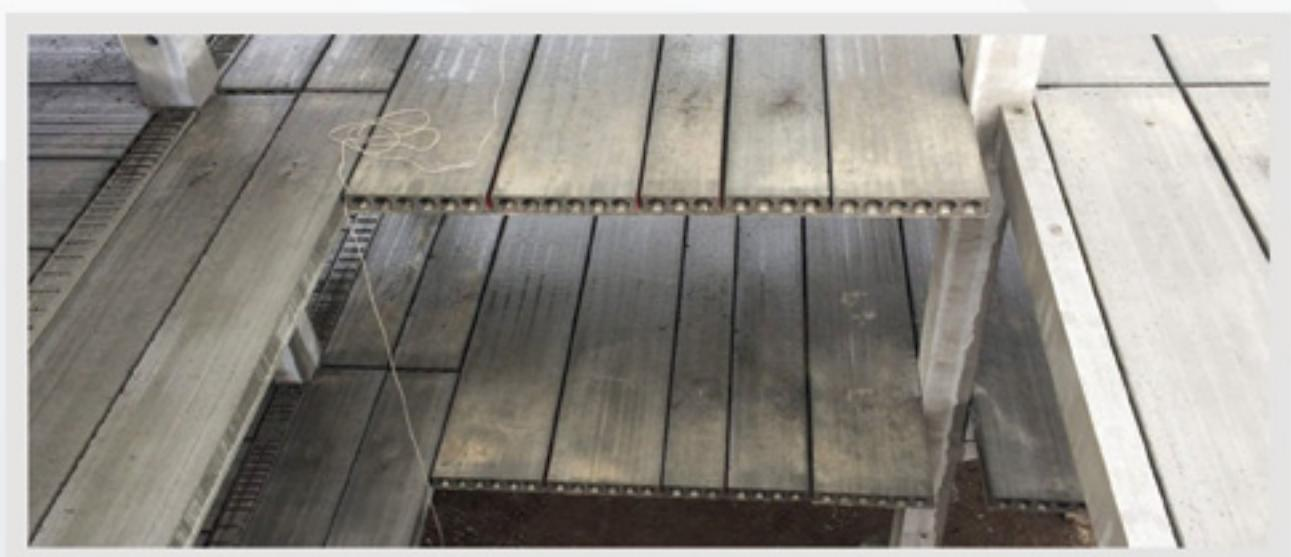
Otvori za stepenice, kamine i krovne prozore, ako nema druge potpore, mogu se napraviti konstrukcijom zamenskih nosača (vekslom). Zamenski nosač se isporučuje zajedno sa prednapregnutim šupljim pločama.
